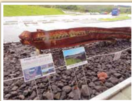
崩落した阿蘇大橋の鉄骨
