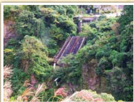
落橋した阿蘇大橋
