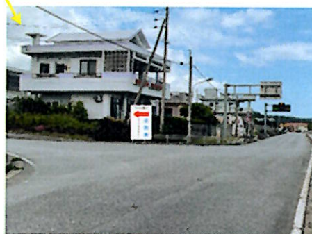
国道 331 号・県道 70 号線 T 字路
