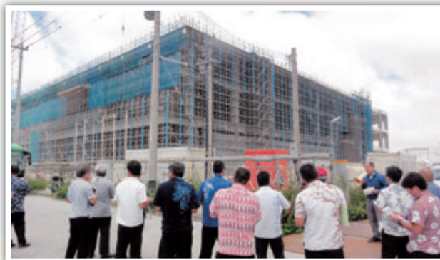
那覇港総合物流センター
