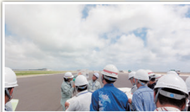
那覇空港第二滑走路埋立工事現場
