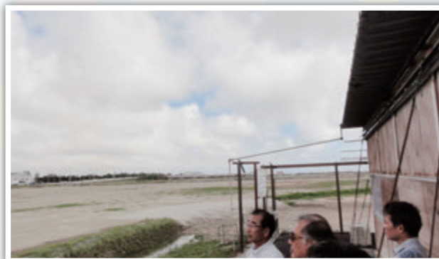
豊崎ロジパーク(仮称) 工事現場
